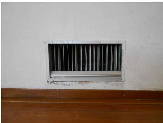
Figura 4.10 - Particolare della tubazione metallica dell’UTA con bocchetta d’aerazione
